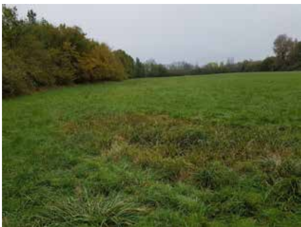
Mare EPIDE avant les travaux
