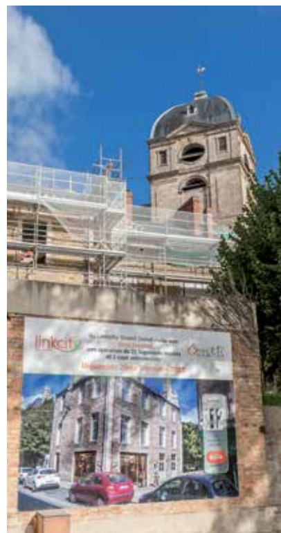
Opération 01 : Réhabilitation en cours de logements au parc de la Providence
