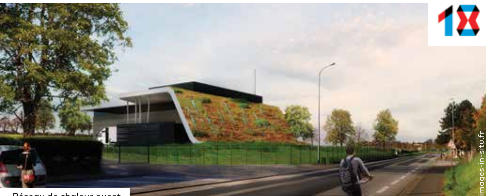
Réseau de chaleur ouest
