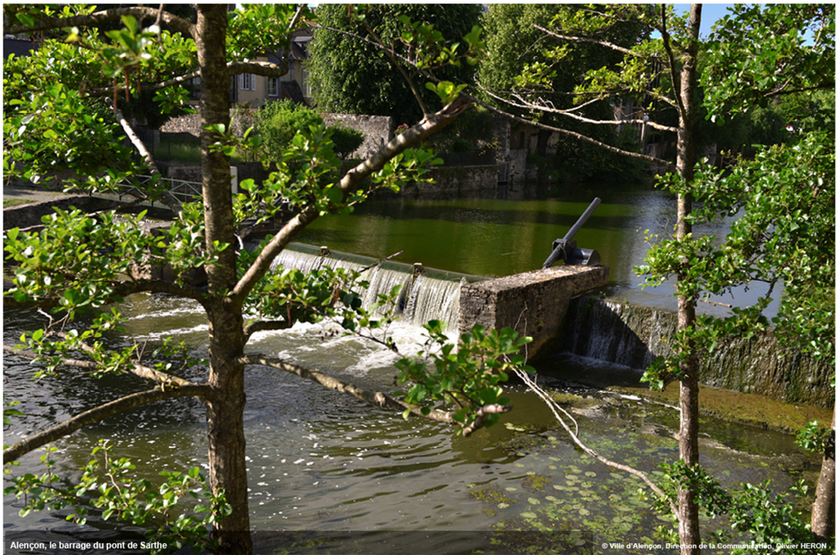
Le barrage du Pont de Sarthe
